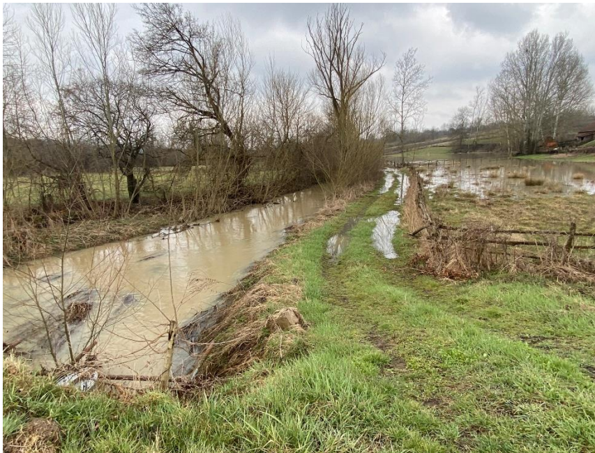
Плављење узводно од локалног пута због урушеног пропуста
