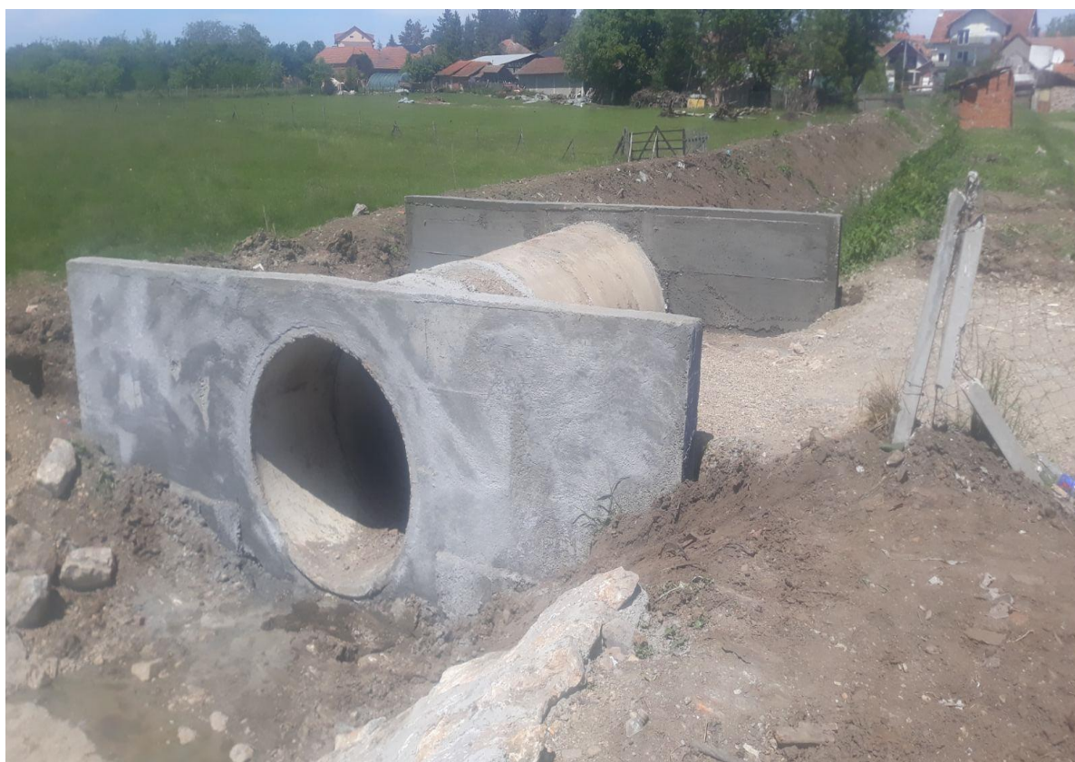
Мићаковаки поток – цевасти пропуст \Phi 1000 код сточне пијаце
