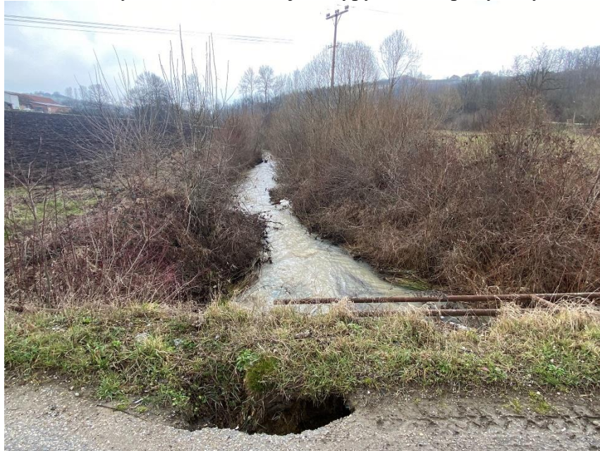
Оштећење цевастог пропуста на локалном путу
